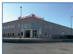
STABILIMENTO Via Vincenzo Pirani, 1 60131 Ancona (AN)
